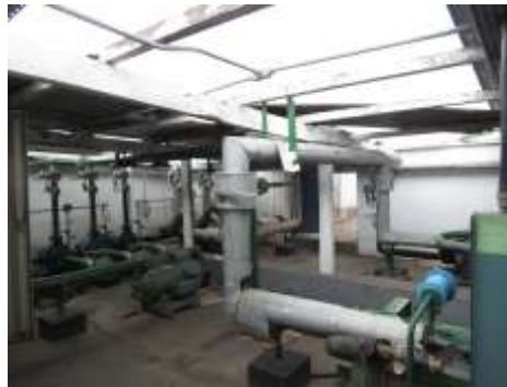
Foto 09 entre Cobertura 1 e 2 equipamentos a serem retirados
