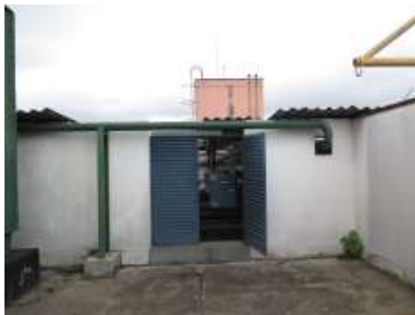
Foto 11 entre Cobertura 1 e 2, porta a retirar e parede a demolir.
