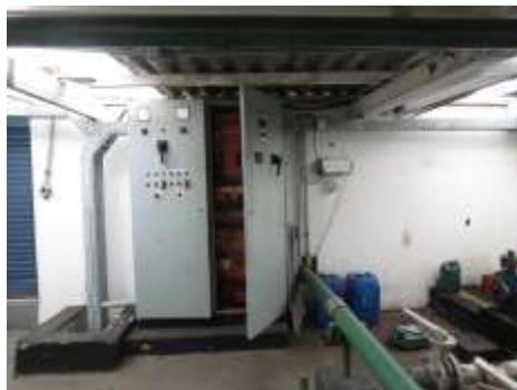
Foto 12 entre Cobertura 1 e 2, equipamentos e quadro elétrico a retirar.
