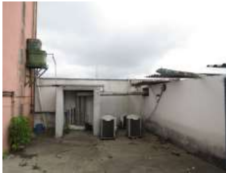
Foto 10 entre Cobertura 1 e 2 equipamentos e telhas a serem retirados
