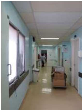
Foto 01 Circulação 01 h=2,50m Forro Acústico.
