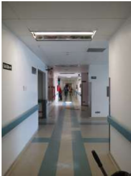
Foto 03 Circulação 02 h=2,47m Forro Gesso.
