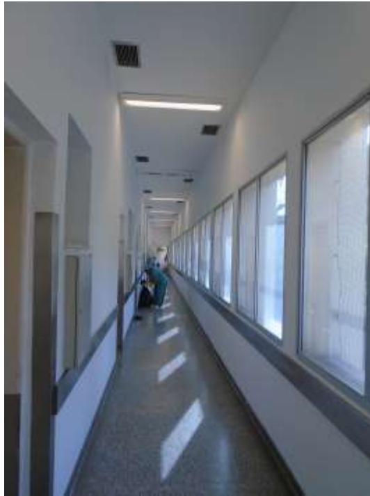
Foto 02 Circulação interna h=3,20m Forro Gesso novo.
