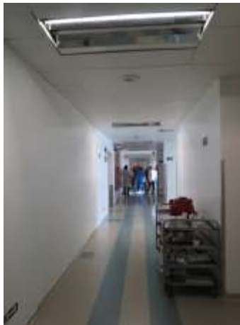
Foto 01A Circulação 01 h=2,50m Forro Gesso.
