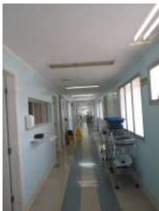
Foto 04A Circulação 04 h=2,36m Forro Gesso.
