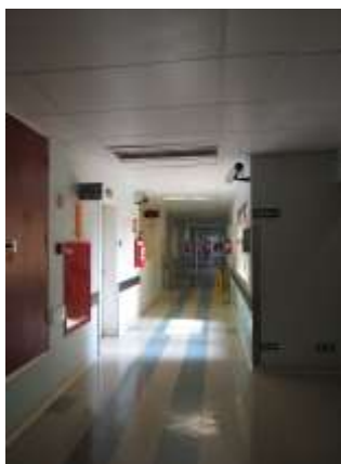
Foto 04 Circulação 03 h=2,46m Forro Gesso.
