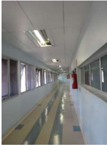
Foto 05 Circulação 05 h=2,49m Forro Gesso.
