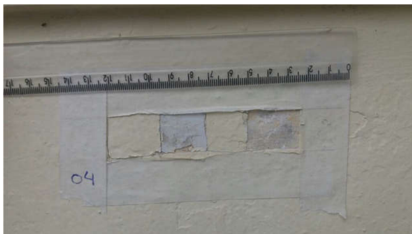
FOTO 12 DETALHE ESTRATIGRÁFICO DO PANO DE FACHADA PRINCIPAL/PÓRTICO DE ENTRADA COR PANTONE – 000/ OURO BRANCO A162
