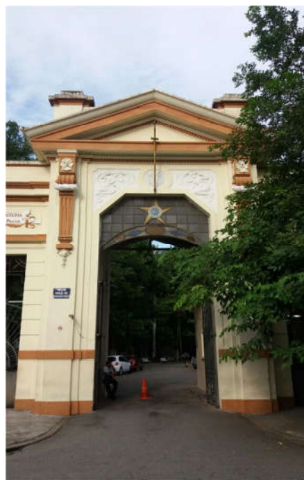
FOTO 02 PROSPECÇÃO ESTRATIGRÁFICA DA FACHADA DETALHE DO PÓRTICO DE ENTRADA
