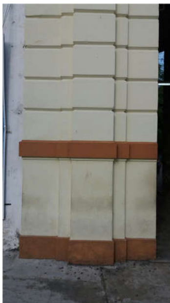
FOTO 06 DETALHE PILAR DO PÓRTICO DE ENTRADA FACHADA HOSPITAL GUILHERME ÁLVARO
