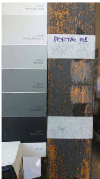
FOTO 20 DETALHE ESTRATIGRÁFICO DA ESQUADRIA DO PORTÃO PRINCIPAL/PÓRTICO DE ENTRADA COR PANTONE – 421 U/CINZA ASFALTO P161
