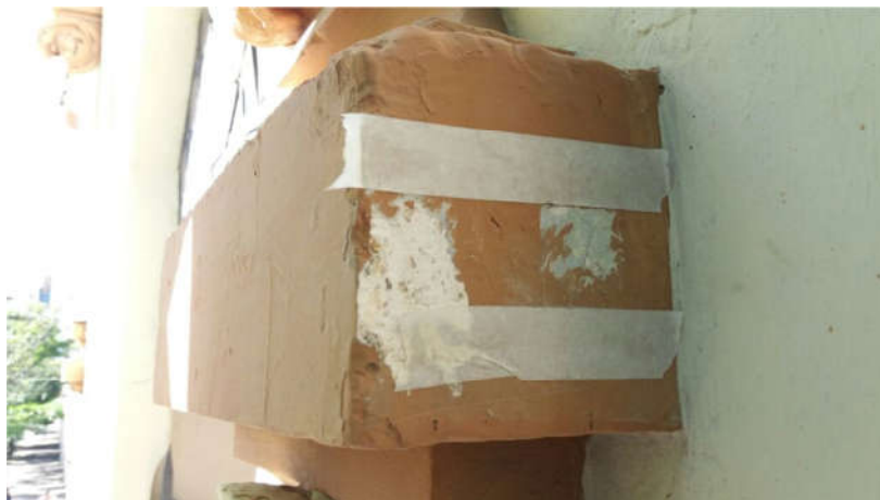
FOTO 27 DETALHE ESTRATIGRÁFICO DE PLINTO DECORATIVO DE FECHAMENTO DO PÓRTICO/PRINCIPAL DA FACHADA COR PANTONE – 421 U/ PRATA C161
