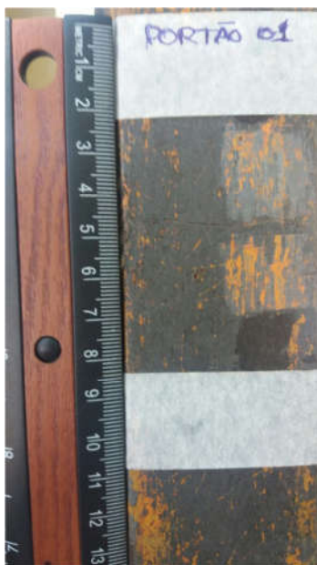
FOTO 19 DETALHE ESTRATIGRÁFICO DA ESQUADRIA DO PORTÃO PRINCIPAL/PÓRTICO DE ENTRADA COR PANTONE – 421 U/CINZA ASFALTO P161
