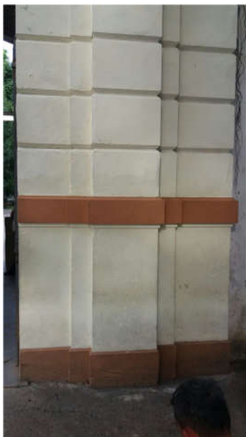
FOTO 05 DETALHE PILAR DO PÓRTICO DE ENTRADA FACHADA HOSPITAL GUILHERME ÁLVARO
