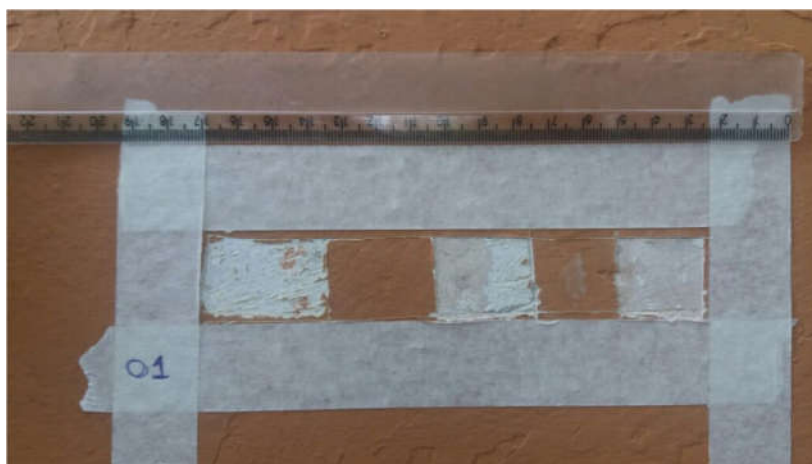
FOTO 08 DETALHE ESTRATIGRÁFICO DA MOLDURA DE RODA-MEIO DA FACHADA PRINCIPAL/PÓRTICO DE ENTRADA COR PANTONE – 421 U/ PRATA C161
