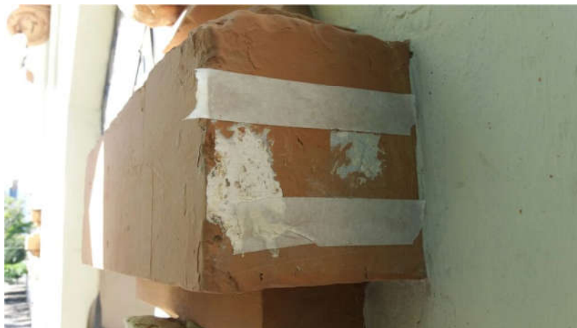
FOTO 28 DETALHE ESTRATIGRÁFICO DE PLINTO DECORATIVO DE FECHAMENTO DO PÓRTICO/PRINCIPAL DA FACHADA COR PANTONE – 421 U/ PRATA C161
