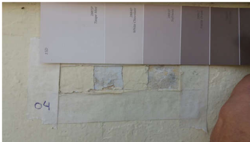
FOTO 13 DETALHE ESTRATIGRÁFICO DO PANO DE FACHADA PRINCIPAL/PÓRTICO DE ENTRADA COR PANTONE – 000/ OURO BRANCO A162
