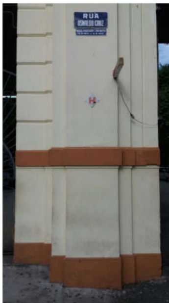
FOTO 03 DETALHE PILAR DO PÓRTICO DE ENTRADA FACHADA HOSPITAL GUILHERME ÁLVARO
