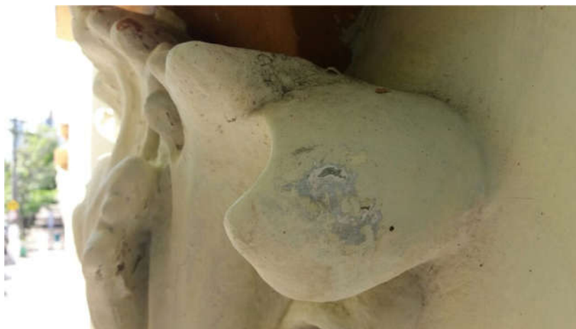
FOTO 29 DETALHE ESTRATIGRÁFICO DE FLORÃO DE ORNAMENTO PRINCIPAL/PÓRTICO DE ENTRADA COR PANTONE – 420 U/CRÔMIO B161
