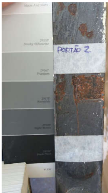
FOTO 21 DETALHE ESTRATIGRÁFICO DA ESQUADRIA DO PORTÃO PRINCIPAL/PÓRTICO DE ENTRADA COR PANTONE – 421 U/CINZA ASFALTO P161
