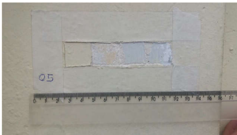
FOTO 14 DETALHE ESTRATIGRÁFICO DO PANO DE FACHADA PRINCIPAL/PÓRTICO DE ENTRADA COR PANTONE – 000/ OURO BRANCO A162
