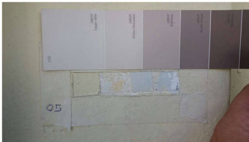
FOTO 15 DETALHE ESTRATIGRÁFICO DO PANO DE FACHADA PRINCIPAL/PÓRTICO DE ENTRADA COR PANTONE – 000/ OURO BRANCO A162
