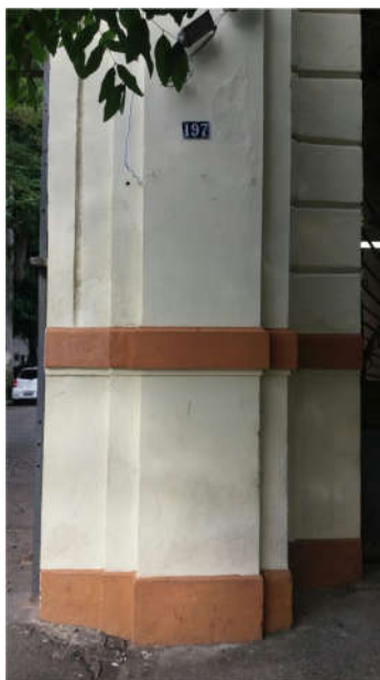
FOTO 04 DETALHE PILAR DO PÓRTICO DE ENTRADA FACHADA HOSPITAL GUILHERME ÁLVARO
